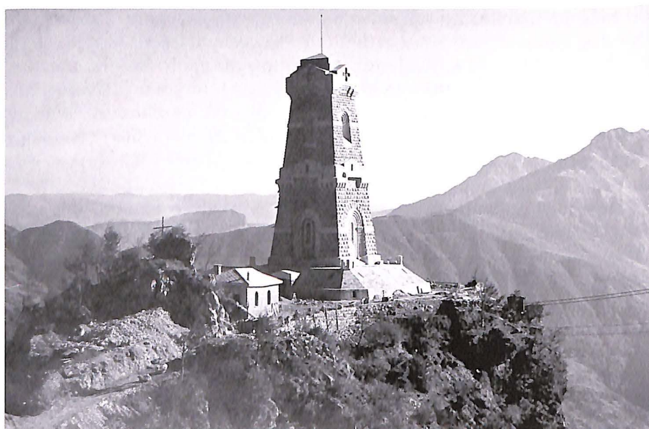
25 ottobre 1925. Ossario del Pasubio. Si stanno posando sulla terrazza le colonnine della balaustrata in pietra bianca della cava di monte Castrazzano. Lo spalto è formato da pietra scura in opera incerta, la stessa dei blocchi strutturali della torre, proveniente dalla cava del monte Cornetto. Le parti architettoniche più luminose sono in pietra bianca di Monte Magrè. Foto di Mario Zuliani. (F.F.C.)
