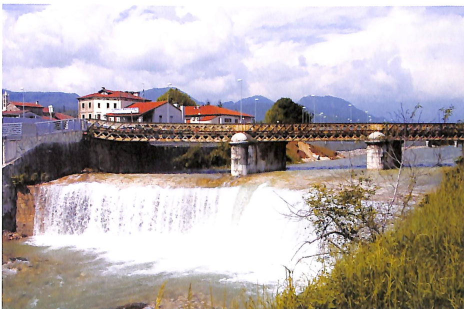
20-21. I due ponti sul Lèogra in località Liviera di Schio. Nel novembre 2001 la nuova opera in calcestruzzo armato ha affiancato quella vecchia, costruita in pietra e ferro, destinata a divenire pista pedonale e ciclabile.
