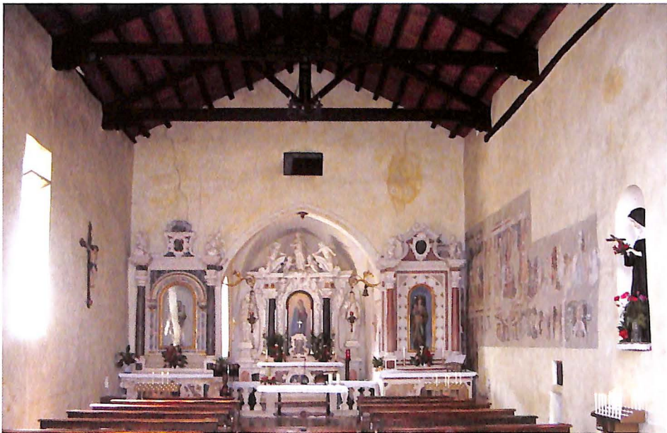
Interno della chiesa dell'Immacolata Concezione, San Vito di Leguzzano. Sulla destra si nota la fascia di affreschi trecenteschi di cui fa parte il brano della Santa Domenica .
