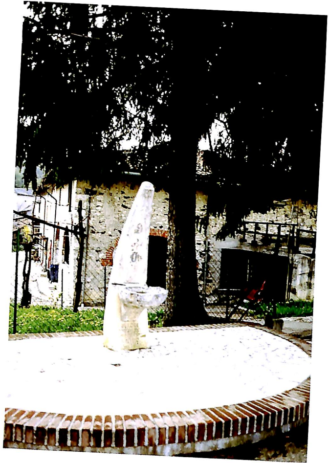
Monumento del 1960, eretto a ricordo del completamento dell'acquedotto di Faedo.
