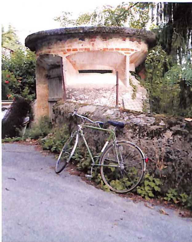
La Scuola di Piovene, una volta adibita a caserma della Milizia Stradale, fu dotata di due garitte lungo la strada delle cave di pietra. La foto mostra ciò che rimane dell'unico posto di guardia ancora esistente (foto Riccardo Grotto).
