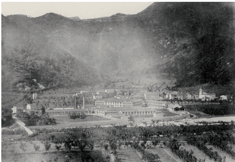
Panorama di Pievebelvicino nel 1912 ripreso da Robert Harth, fotografo di Schio, con l'opificio Filanda della Lanerossi in posizione centrale. Sulla facciata nord-ovest dell'edificio si distingue la capannina con grigliatore d'ingresso della roggia nella primitiva centrale idroelettrica. Lo scantinato del capannone centrale è la sede della vecchia cartiera (Archivio Biblioteca Duomo Schio).
