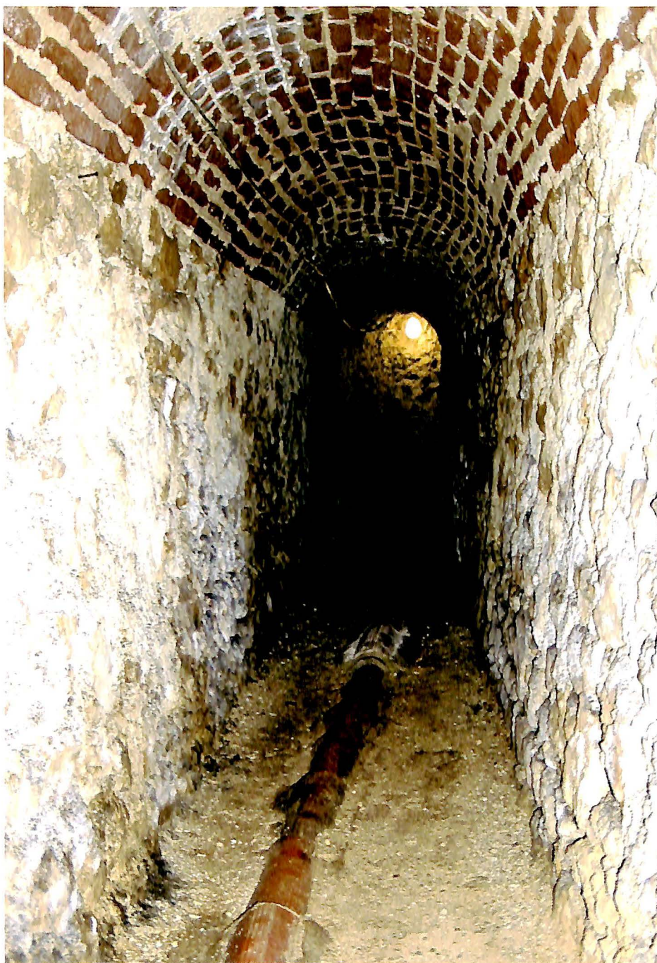
Fig. 4 - Galleria interna alla Birreria Rossi. Sul terreno, protetto da coppi in cotto, si nota il condotto che porta l'acqua all'esterno.
