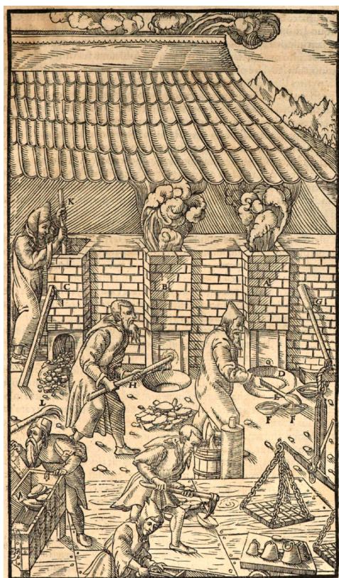
Fig. 2: Fusione del piombo, da AGRICOLA, p. 313.
